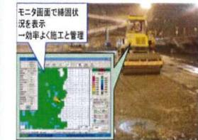
TSやGNSSにより締固め機械の位置を取得し、走行軌跡や締固め回数をリアルタイムに運転席モニタへ提供する
