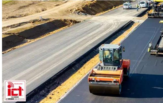
SmartRoller(スマートローラー)は、GNSS、TSを用いたICT転圧管理システムです。締固め工や舗装工などにおいて、「どの場所を、何回転圧したか」を、走行軌跡を用いて面的に管理することができます。クラウドサーバを介した現場との迅速なやり取り、データの一元化による業務の効率化とスピードアップで、管理者・オペレータの省力化につながります。
