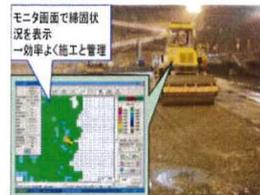
TSやGNSSにより締固め機械の位置を取得し、走行軌跡や締固め回数をリアルタイムに運転席モニタへ提供する
