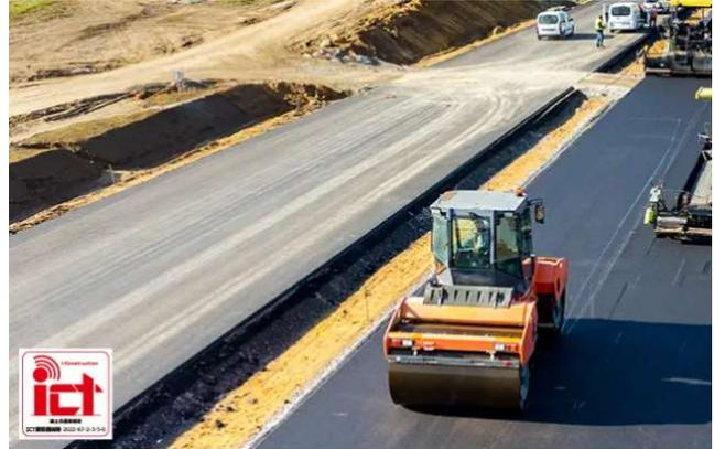
SmartRoller(スマートローラー)は、GNSS、TSを用いたICT転圧管理システムです。締め固め工や舗装工などにおいて、「どの場所を、何回転圧したか」を、走行軌跡を用いて面的に管理することができます。クラウドサーバを介した現場との迅速なやり取り、データの一元化による業務の効率化とスピードアップで、管理者・オペレータの省力化につながります。
