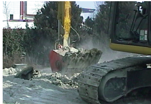
ドライブミキシング作業現場
