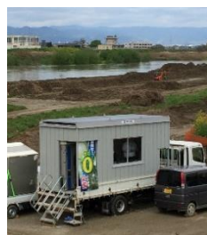
■ 河川工事での使用例
