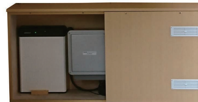
既存のユニットハウスへの取付
